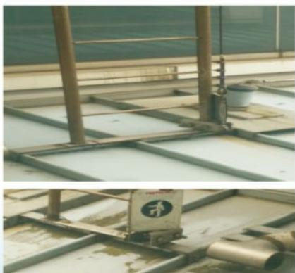
於易踏穿材料構築之屋頂作業時，應先規劃安全通道，於屋架上設置適當強度，且寬度在三十公分以上之踏板，並於下方適當範圍裝設堅固格柵或安全網等防墜設施。
